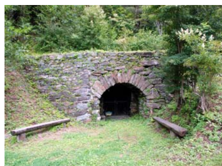
第一通洞南口（代々坑）
