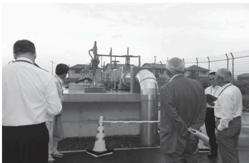
監査現地視察の様子：新山根配送水場
