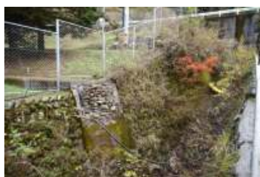
写真 3-41 対面側の配線用カルバート跡
