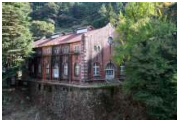
写真 6-8 本建物正面玄関
