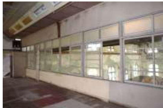
写真 3-15 配電盤室 2階西面
