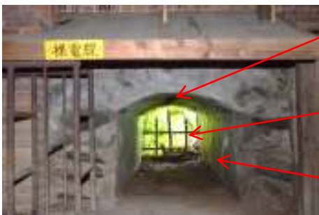
床下倉庫風洞 室内から外を見る
