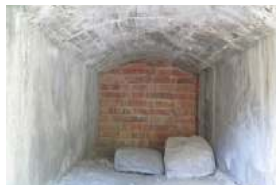
写真 3-46 A-8 石垣側から内部を見る
