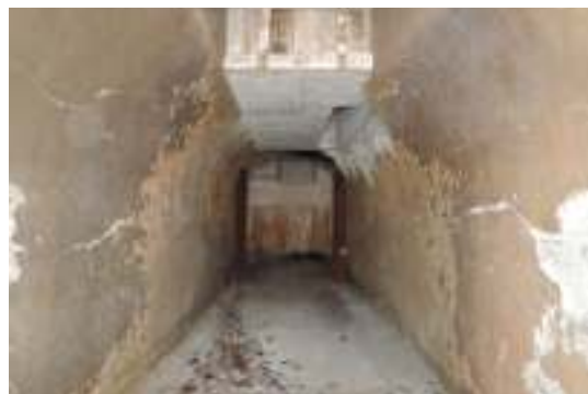
写真 3-48 W-3 を石垣側から内部を見る
