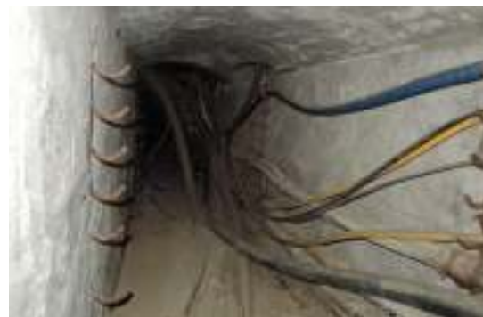
写真 3-42 電線孔内部の様子
