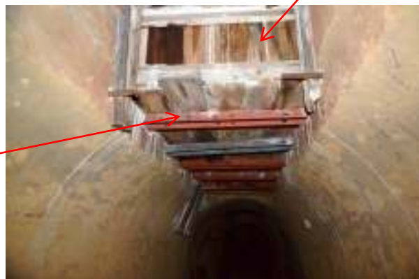
北側排水路 FC2 下（旧第一水車発電機部分）
