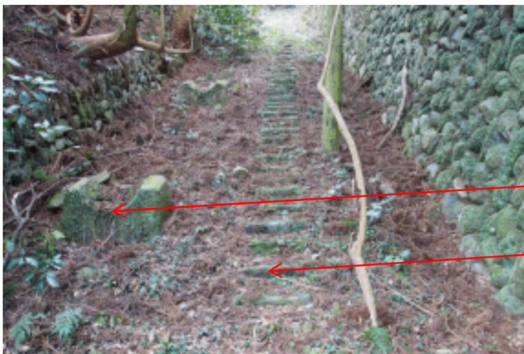
l. 水圧鉄管台座と石段
