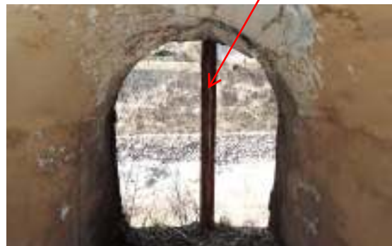
FC1,2 風洞（旧第三水車発電機排水路）排水口
