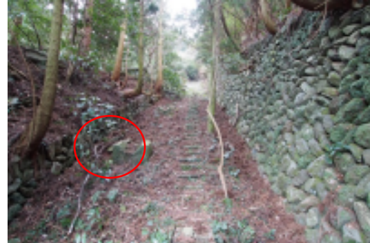
写真 4-6 県道山側の水圧鉄管遺構 赤丸部分が鉄管の台座
