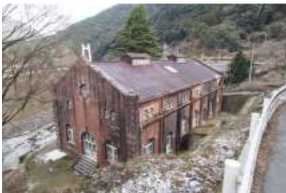
写真 4-1 県道から建物を望む
