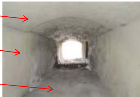
FC1 旧南側風洞 中央から外を見る
