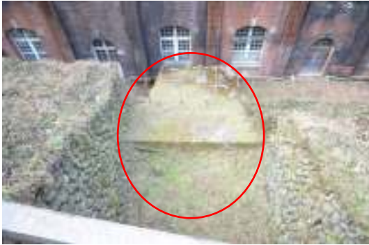
写真 4-5 水圧鉄管を覆うコンクリート
