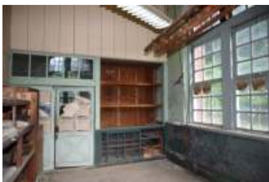
写真 3-8 事務室南西面
