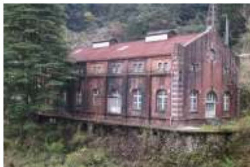
写真 6-23 建物北側通路と西面入口
