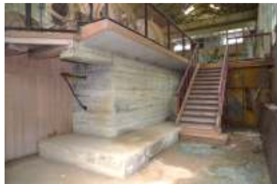
写真 3-33 旧特別高圧室 後設壁
