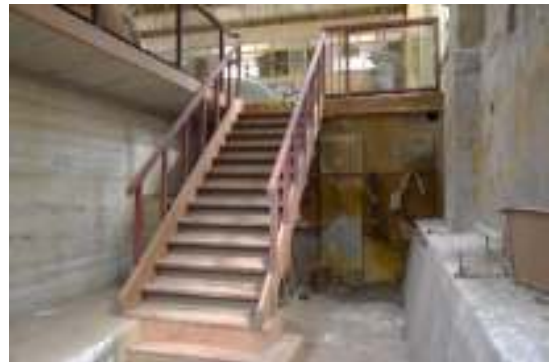
写真 3-19 旧特別高圧室 階段
