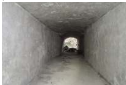
写真 3-44 A-4 内側から外部を見る
