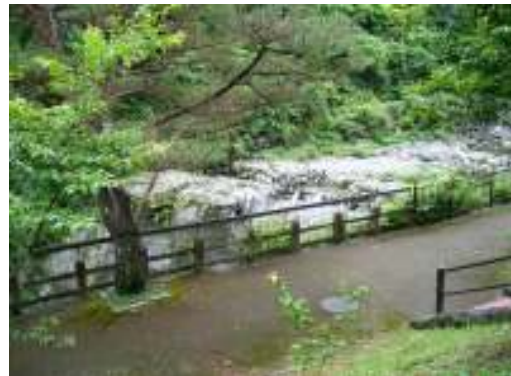
写真 6-20 マイントピア別子側からの堰堤
