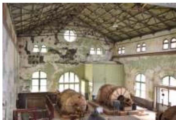
写真3-2 建物内部 西面
