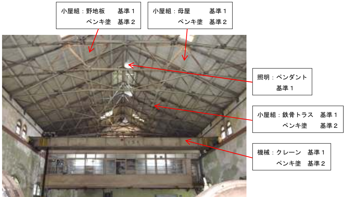
タービン室 天井
