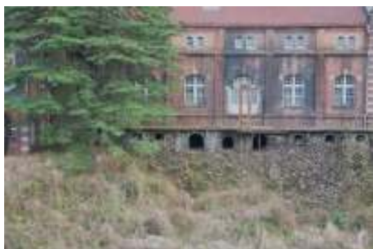
写真 6-24 地下水抜き穴と風穴
