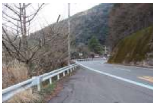
写真 6-14 写真奥のカーブに張出を設置
