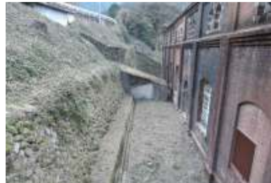
写真 4-8 建物南側の石垣
