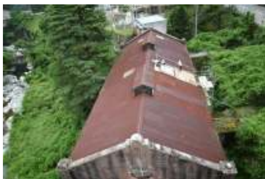
写真3-4 屋根 西から東を望む
