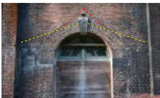
写真 3-38 南東開口部 屋根取付き詳細
