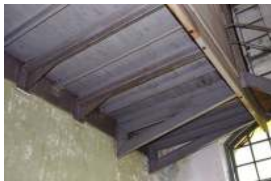
写真 6-29 2階片持ち部分
