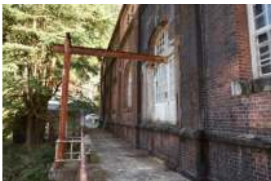
写真3-3 北面中央出入口
