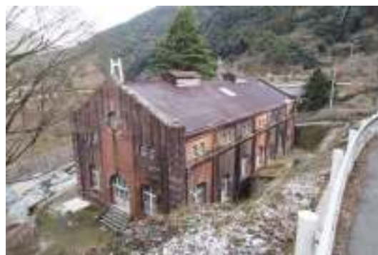
写真 4-13 県道側敷地内の様子
