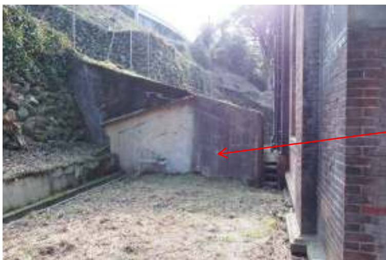
a. 水圧鉄管を覆うコンクリート
