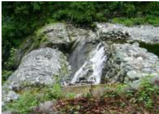
写真 6-19 マイントピア別子側からの堰堤
