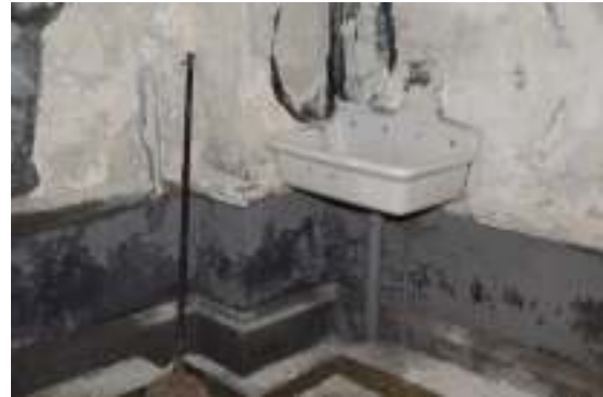
写真 3-13 北東隅の洗面器
