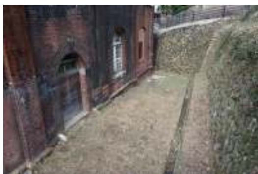
写真 4-11 敷地南側排水溝
