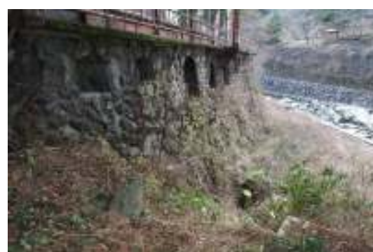
写真 6-25 地下水抜き穴と風穴詳細
