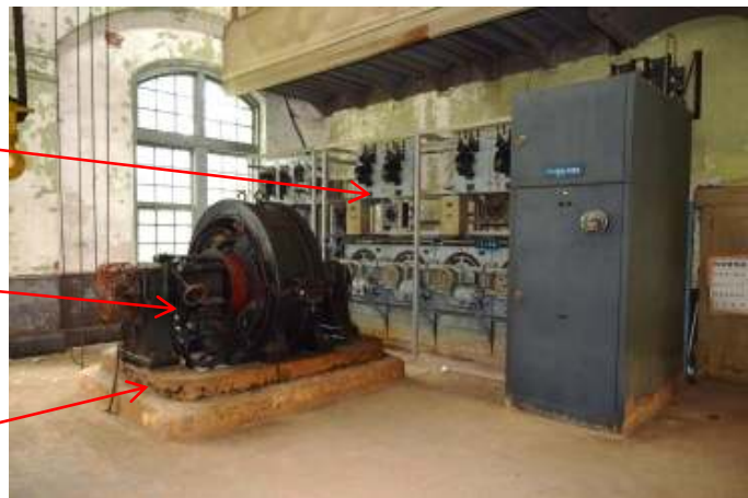
回転変流機・制御盤
