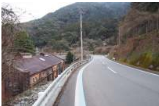
写真 4-12 建物南側の県道
