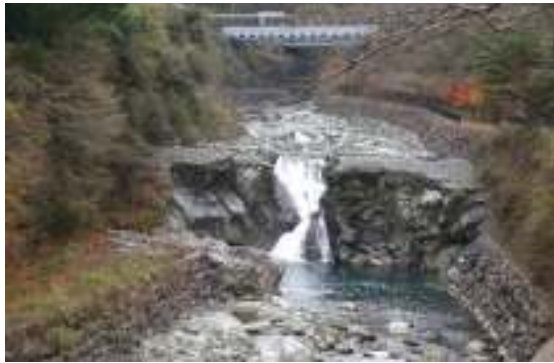
写真 6-17 建物東側の堰堤
