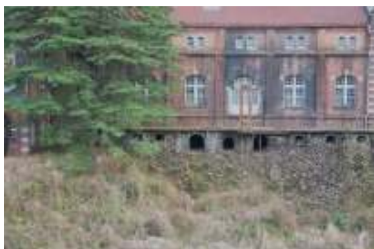
写真 6-24 地下水抜き穴と風穴
