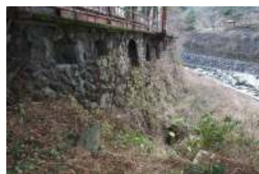
写真 6-25 地下水抜き穴と風穴詳細
