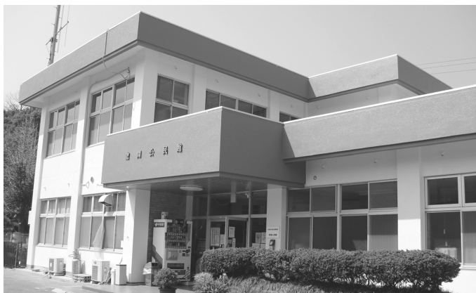
惣開公民館外壁塗装整備
