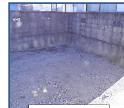
整備された跡地
