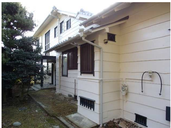
写真 2-21 外国人東社宅 北面西
