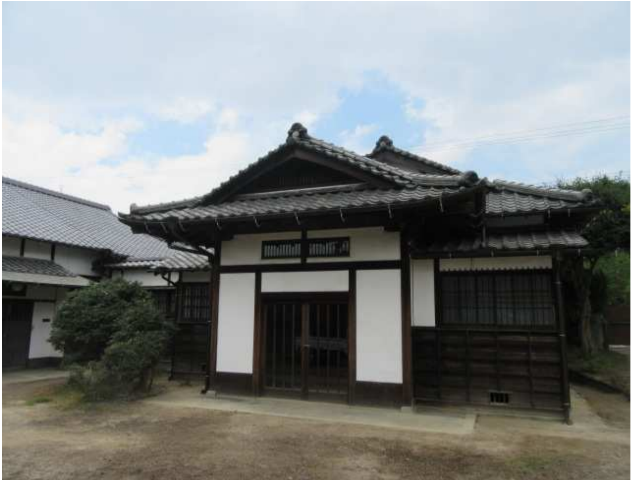
写真 2-2 別子鉱業所長社宅 玄関(応接棟東面)
