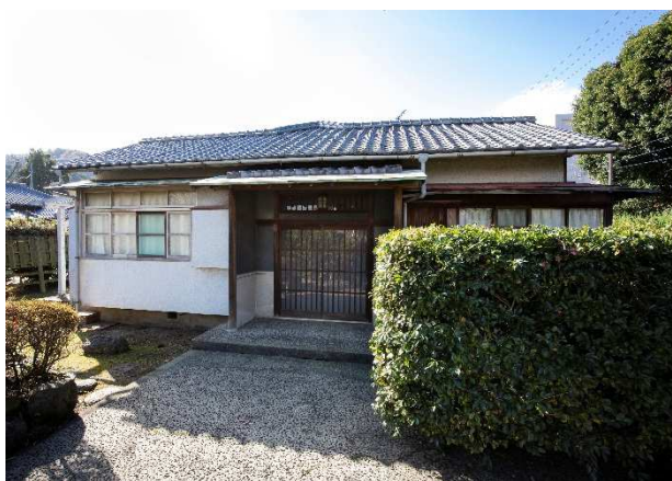
写真 2-24 共電監査役社宅 玄関(東面)
