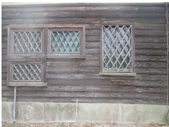
写真 2-10 住友化学幹部社宅 東面窓
