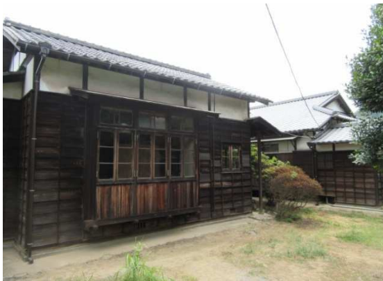
写真 2-3 別子鉱業所長社宅 応接棟西面
