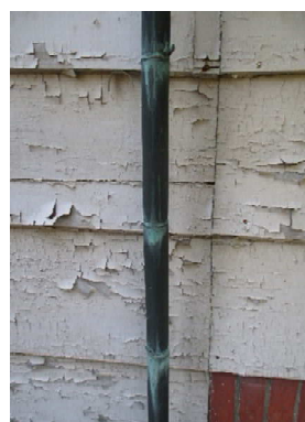
写真 2-17 外国人西社宅 銅製竹型縦樋
