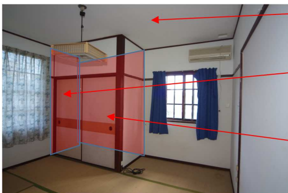
東面(押入れ妻面北側)
