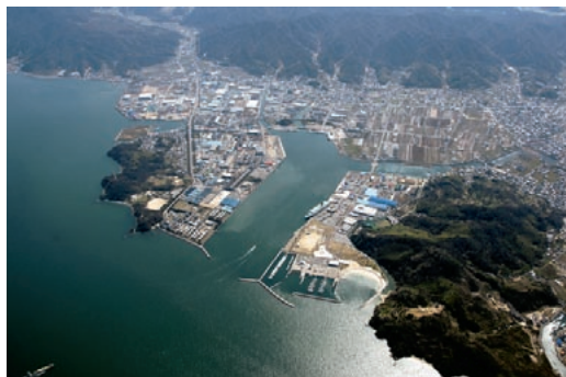
▲新居浜港東港地区
