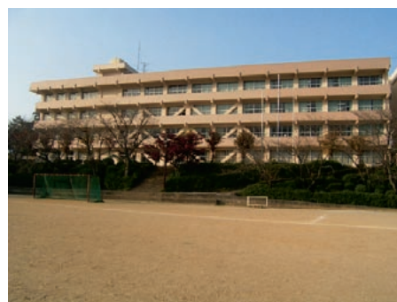
▲学校校舎耐震化工事
