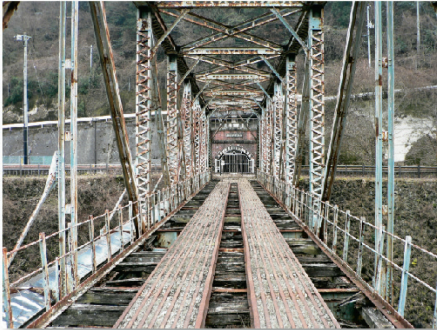
▲四通橋と第四通洞
