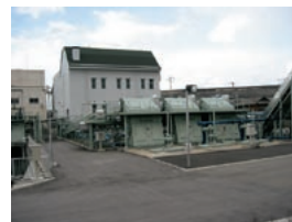
▲ 土場ポンプ場
