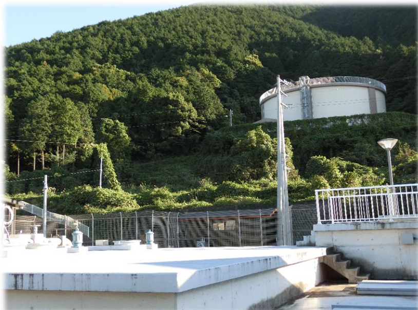
新山根送水場・配水池
