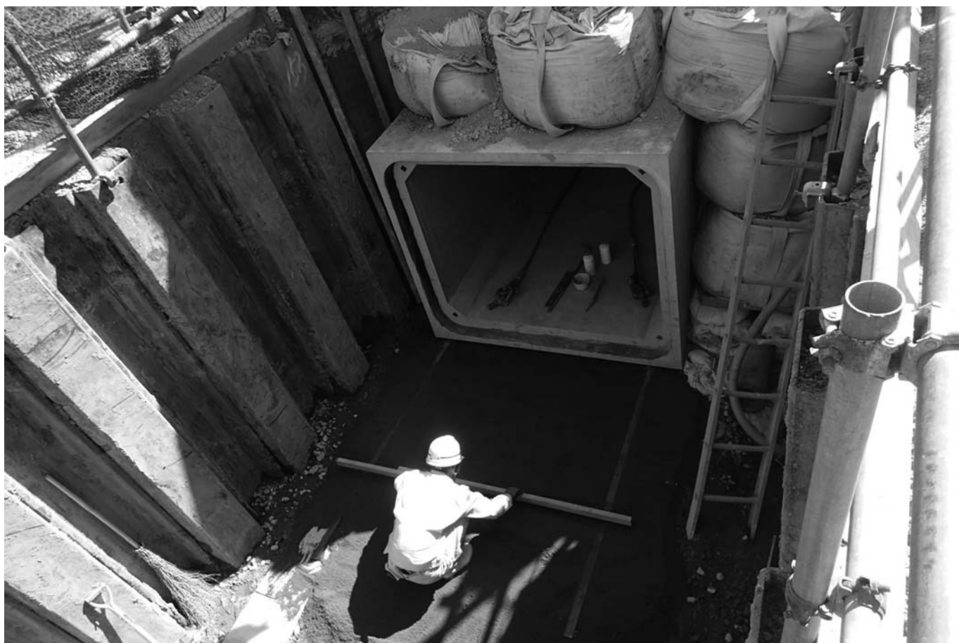
雨水排水施設の建設状況
