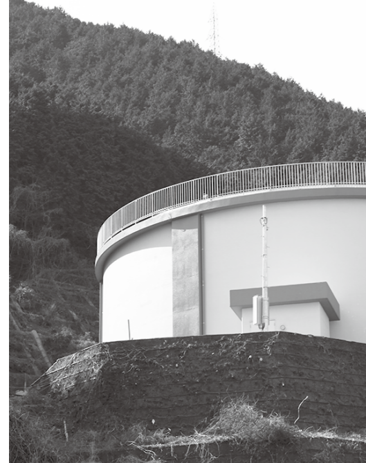
新山根配水池
