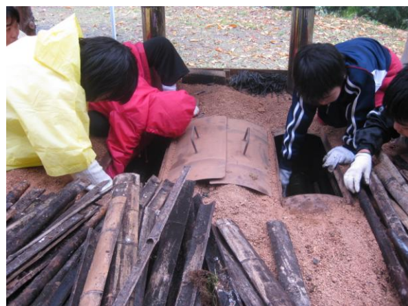
竹を四枚に割ったものを底から隙間なく徐々に敷き詰めていきます。
