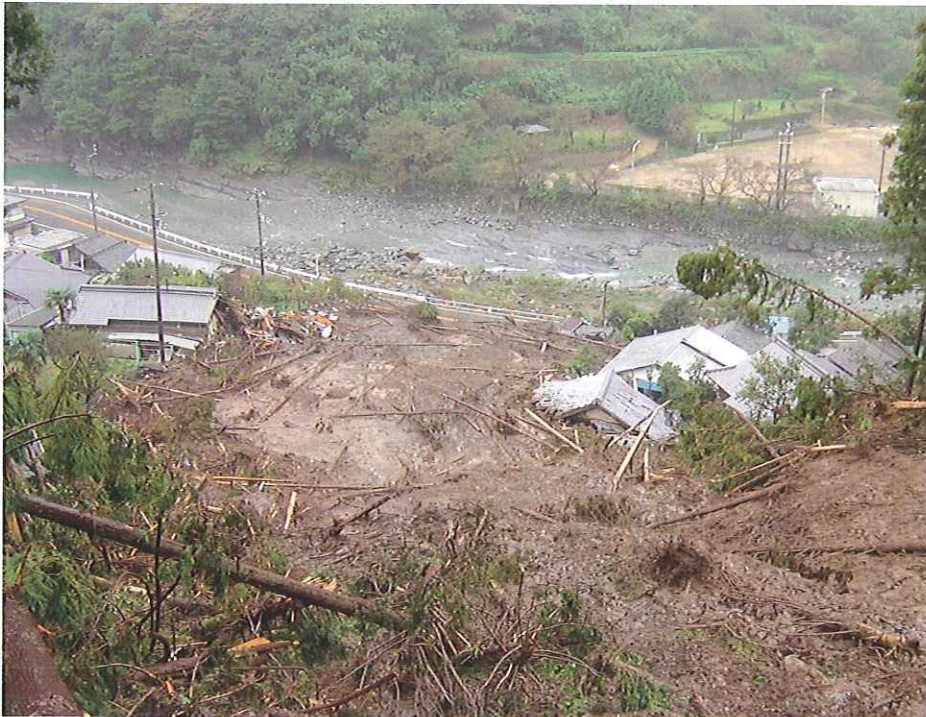
(写真:平成16年集中豪雨による立川新道地区土砂崩れ現場 2004.10.19撮影)
