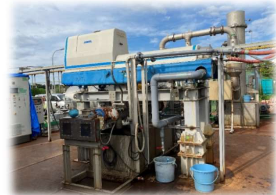
新居浜市における燃料化 実証事業の様子（令和5年8月）
