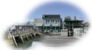
雨水ポンプ場・樋門など
