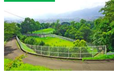
金子山配水池
