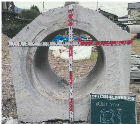
図 2.6 ヒューム管（導水管）の状態
