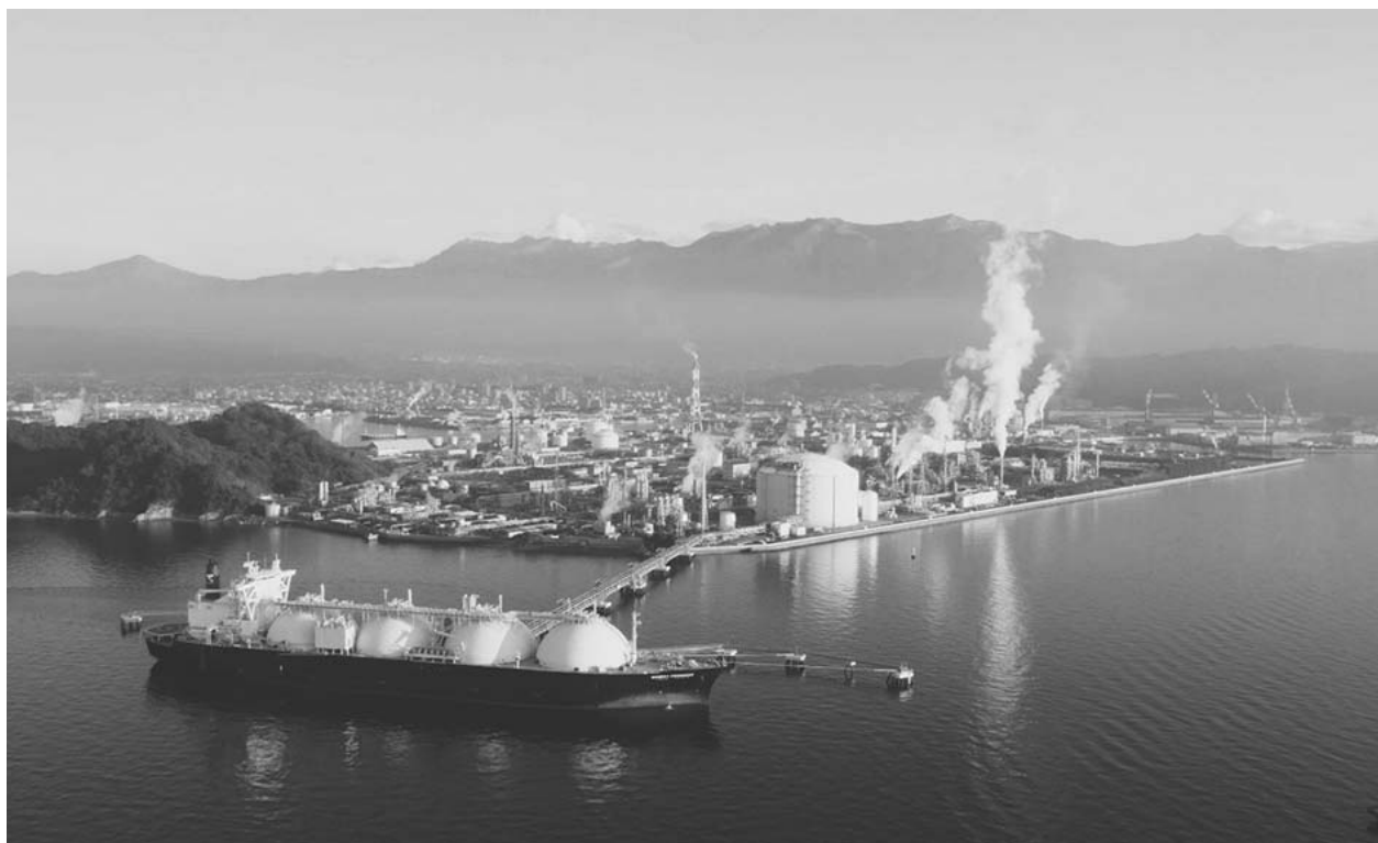
LNGタンカーと新居浜LNG基地
