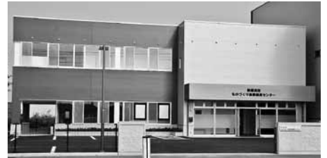
■ものづくり人材育成施設の建設
