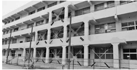
■小・中学校校舎耐震補強工事の実施
