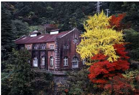
旧端出場水力発電所
