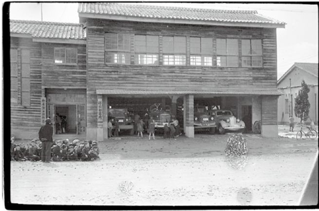
昭和31年3月撮影。車庫の2階には、24年7月～26年8月の間、新居浜簡易裁判所仮庁舎が置かれていました。
