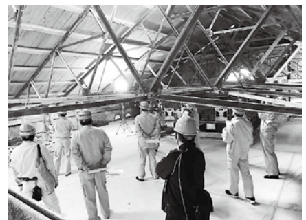
決算特別委員会現地調査 (端出場水力発電所整備事業)
