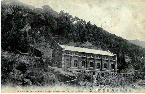
「端出場水力発電所の景」 明治45年頃 絵はがき
