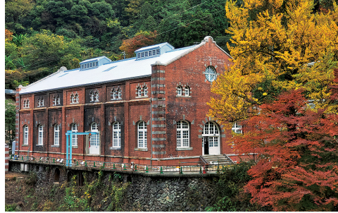
旧端出場水力発電所
