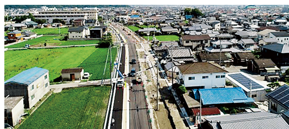
宇高西筋線改良事業 1億4,071万円 令和5年度中の供用開始を目指し、道路改良工事などを実施しました。
