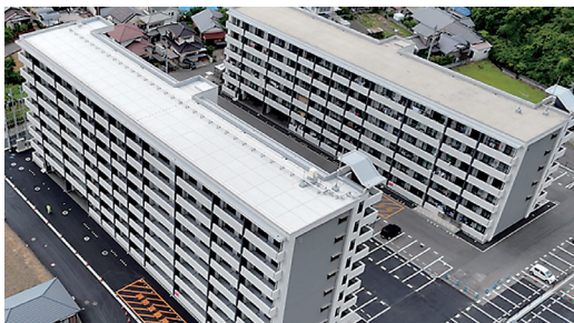
東田市営住宅（2号棟）を建設。
