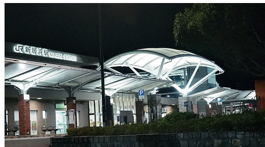
市内照明灯（1,003灯）のLED化を実施。
