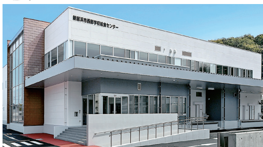
王子町に、西部学校給食センターを建設。
