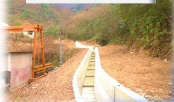
荷内第七川水路改良
