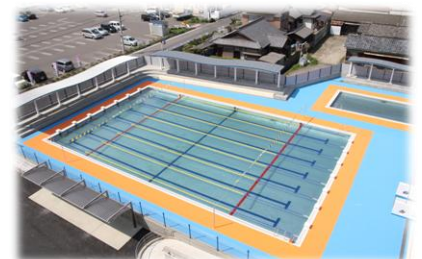
金栄小学校プール
