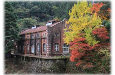
旧端出場(はてば)水力発電所
